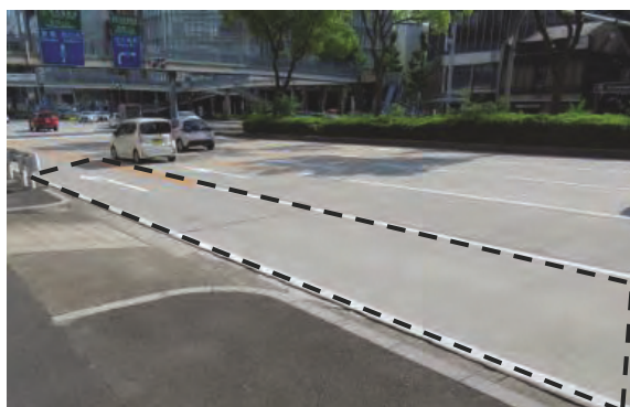
小面積の打換え工事
