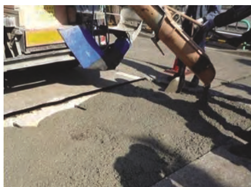
目地部の補修工事
