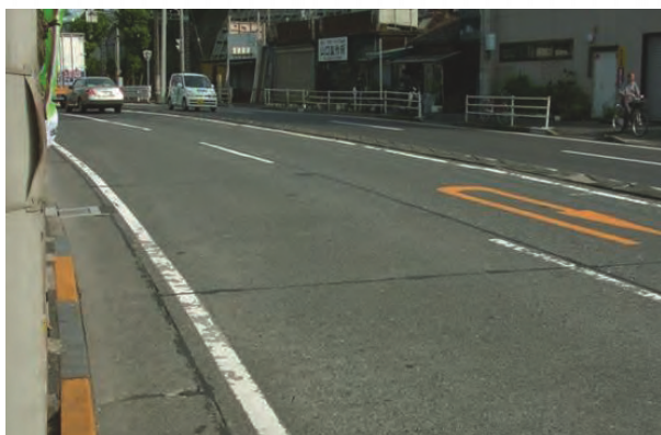
国道16号 神奈川県横浜市 (N7交通、供用61年)
