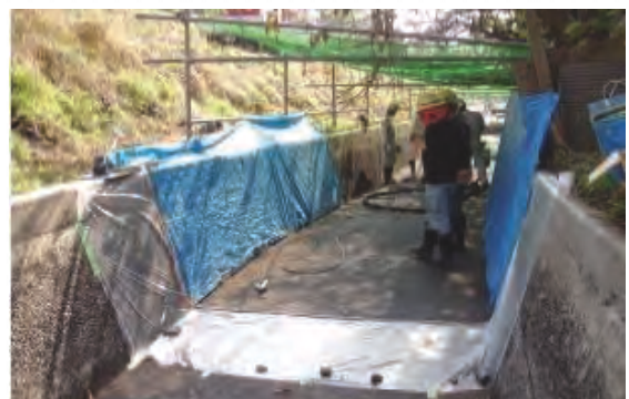
〔シート養生状況〕
