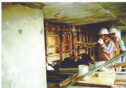
【側面充てんの施工】
