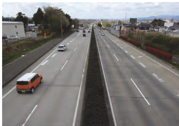
福島県・国道4号郡山西循環道路
