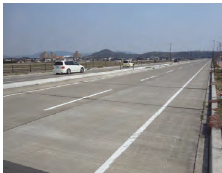
コンクリート舗装
