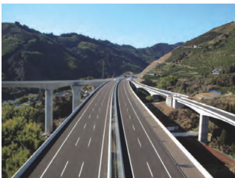
アスファルト舗装
