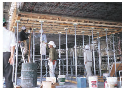
【下面充てんの施工】
