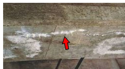
写真 下フランジに発生したエフロレッセンス
