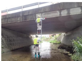
脚立による点検
