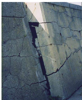
写真 無筋構造物
