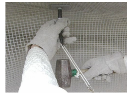
剥落ネットの設置
