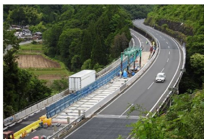
【 提案技術:車線規制施工 】
