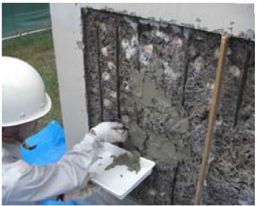
写真 左官工法施工
