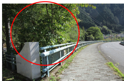
写真 枝葉が鋼桁接触している場合
