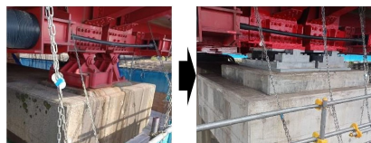
支承高の低い支承に交換することで段差が生じにくくした例
