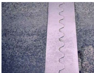
写真 伸縮装置(狭い)
