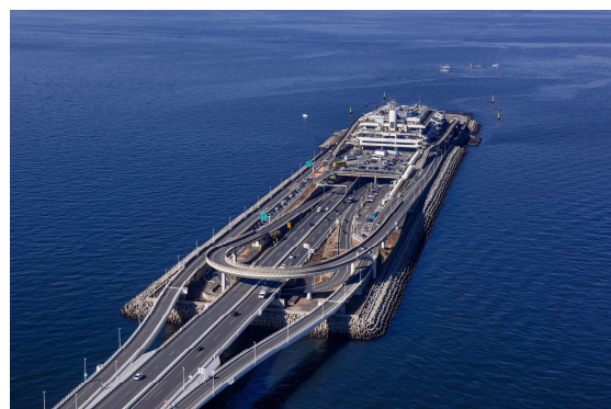
東京湾横断道路（アクアライン）（東日本高速道路㈱）
