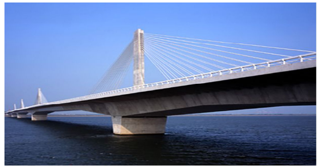
第二名神高速道路 木曾川橋 (日本道路公団)
