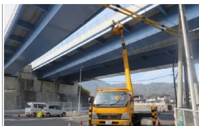
高所作業車による点検
