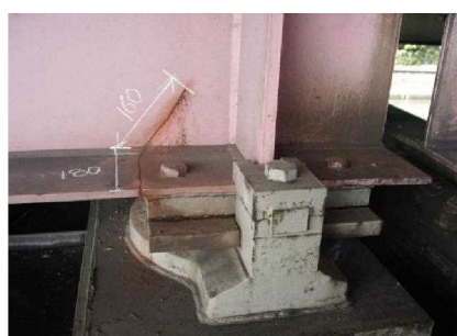
写真 当て板補修
