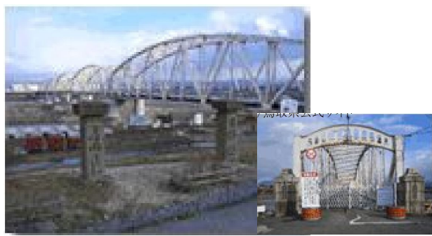
米子市内 日野橋 1929年竣工
