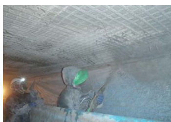
写真 ポリマーセメント吹付
