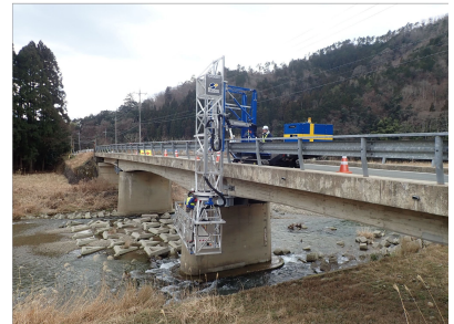
橋梁点検状況
