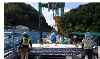
架設・撤去機材
