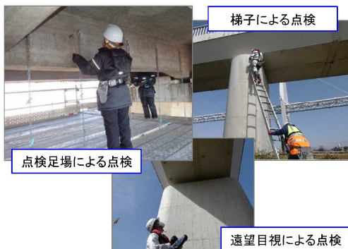
従来技術 梯子や点検足場による近接目視
