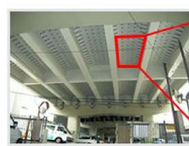
写真 シート貼付け(格子貼り)
