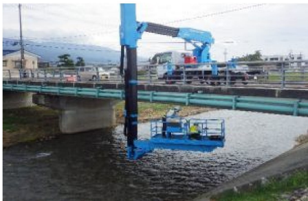
橋梁点検状況
