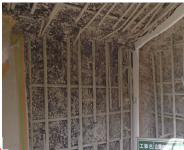
写真 鉄筋防錆材塗布
