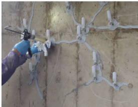
写真 ひび割れ注入
