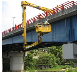
橋梁点検状況
