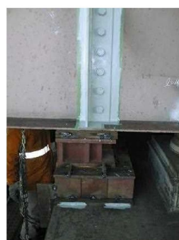
写真 サンドルによる主桁仮受
