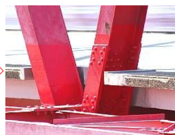
写真 当て板補修完了
