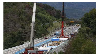
鋼橋RC床版の取替更新
