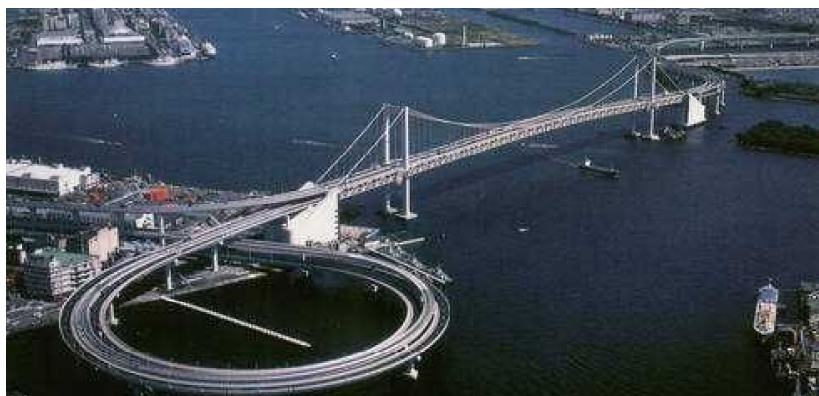
東京港連絡橋 レインボーブリッジ（首都高速道路公団）
