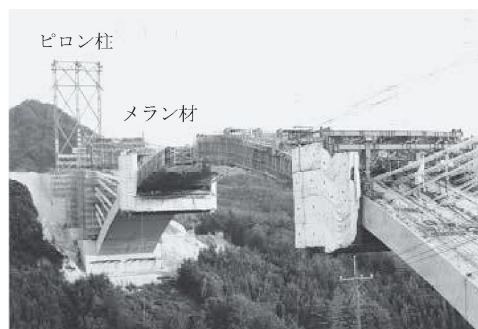
中国自動車道 宇佐川橋 1982年竣工
