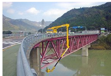
橋梁点検状況
