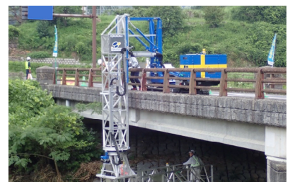
橋梁点検状況
