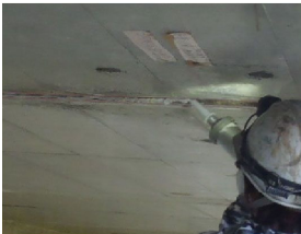
写真 ひび割れ充填
