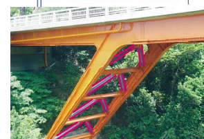
写真 制震補強取付け
