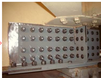
写真 主桁端部部分取替
