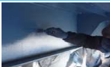
鋼桁塗装の塗り替え補修
