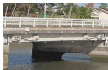
写真 外ケーブル補強
