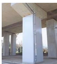
写真 鋼板巻き立て
