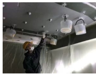
写真 樹脂の注入
