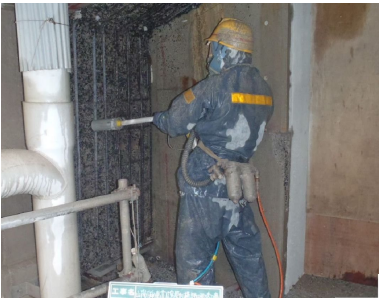
写真 WJによるコンクリートの除去
