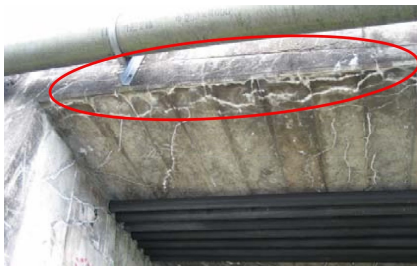
写真 RC中空床版橋
