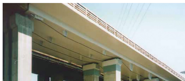
写真 外ケーブル補強
