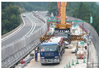
【 従来技術:全面通行止施工 】
