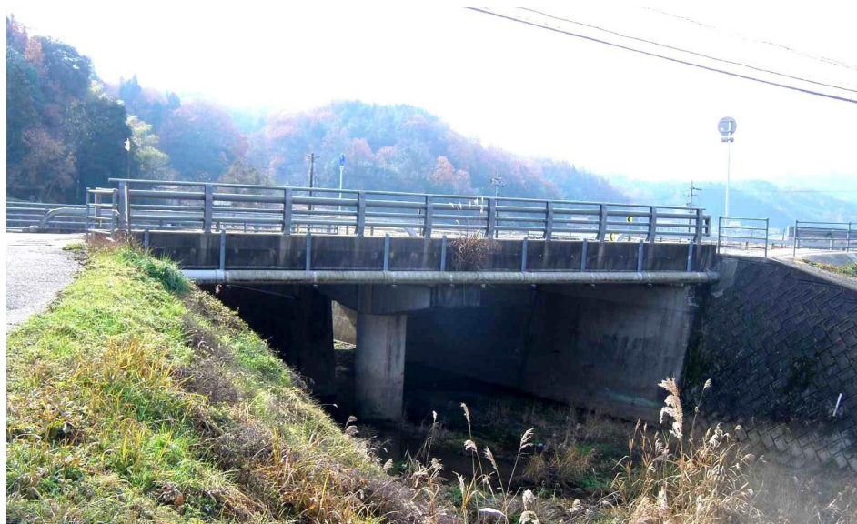
写真 桁側面からの点検ポイント
