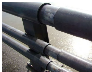
写真 防護柵のジョイント部(広い)
