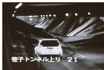
トンネル崩落事故状況
