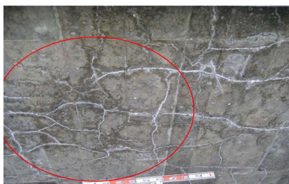
写真 RC中空床版橋
