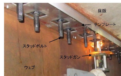
鋼桁の当て板補強施工状況
