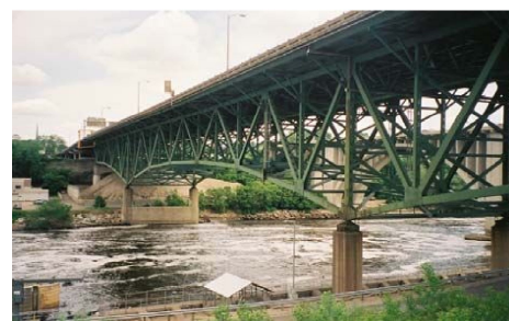
写真 崩壊前の橋梁
