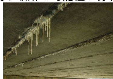
写真 漏水・遊離石灰
