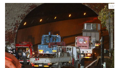
トンネル崩落事故状況
