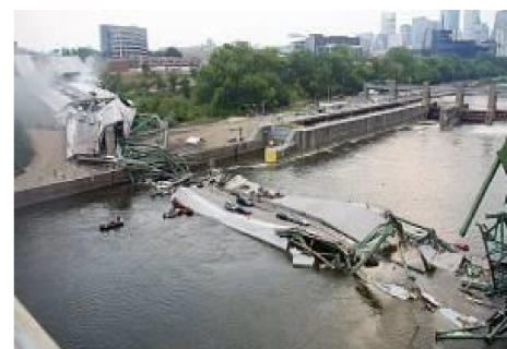
写真 崩壊後の橋梁
