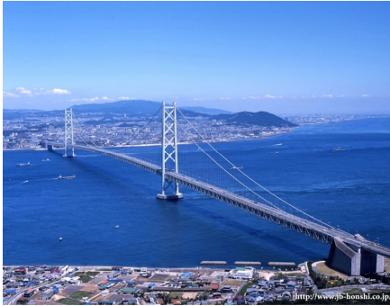
明石海峡大橋 (本州四国連絡高速道路株)
