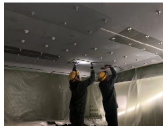
写真 鋼板の接着
