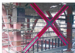
写真 制震補強取付け
