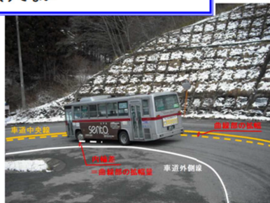
主要地方道 渋川松井田線（群馬県）
