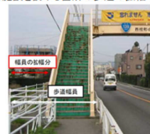
国道139号（山梨県西桂町）
