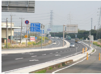
国道17号上武道路(群馬県伊勢崎市)
