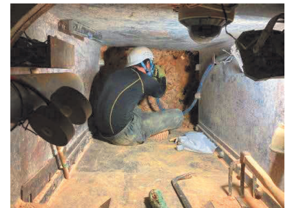
パイプルーフ補助工法 (箱型ルーフ人力掘削状況)
