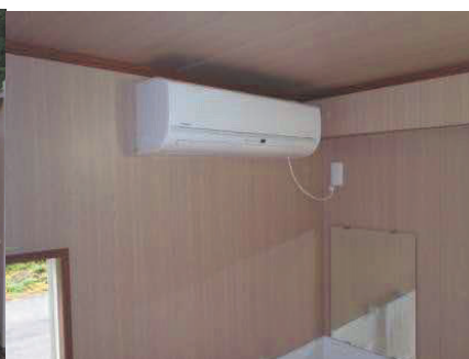
エアコン配備
