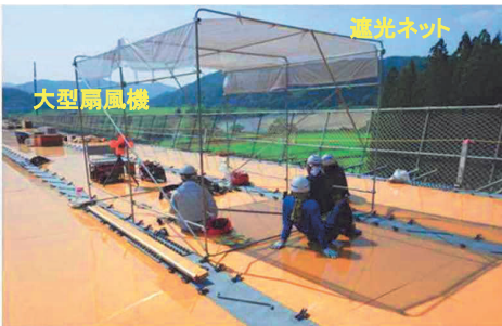
メッシュシートによる遮光設備と大型扇風機の設置
