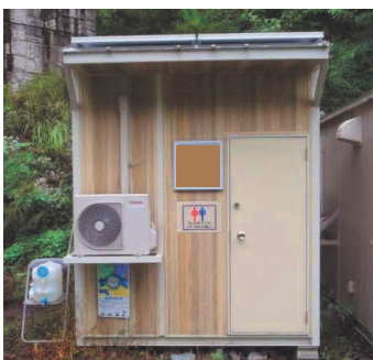
快適トイレ外観
