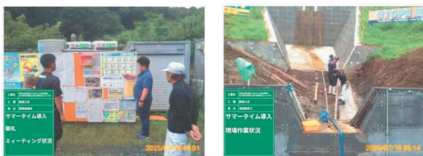
写真1 作業前のKYミーティング
