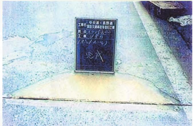
補修箇所を人力で取り壊し、補修材で埋戻す
