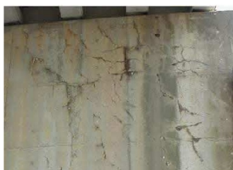
図一解 2.1.4 PC鋼材方向が卓越したひび割れ
