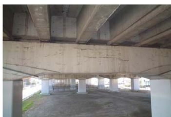
図一解 2.1.3 主鉄筋方向が卓越したひび割れ
